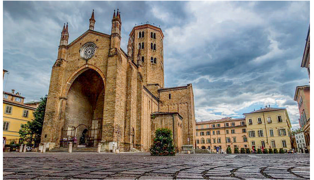
L'impresa Cogni ha realizzato i sottoservizi di Piazza Sant'Antonino e la nuova pavimentazione FOTO MASSIMO MAZZONI
