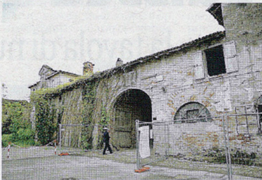
Ecco come si presentava il fronte di Casino Mandelli alla fine di aprile 2012, prima che partissero le opere di recupero strutturale
